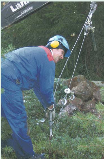
Erkki Kieksi kiinnittää päätepylvään haruksen.
