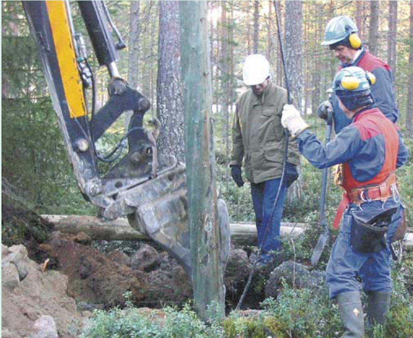
Vanha pylväs on pystytetty lapiolla kaivettuun kuoppaan ja tuettu kivillä, toteavat Kaarlo Pöyliö, Kauko Maajaakkola ja Erkki Kieksi.
