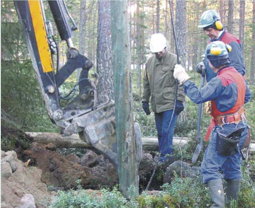
Vanha pylvä on pystytetty lapiolla kaivettuun kuoppaan ja tuettu kivillä, toteavat Kaarlo Pöyliö, Kauko Maajaakkola ja Erkki Kieksi.
