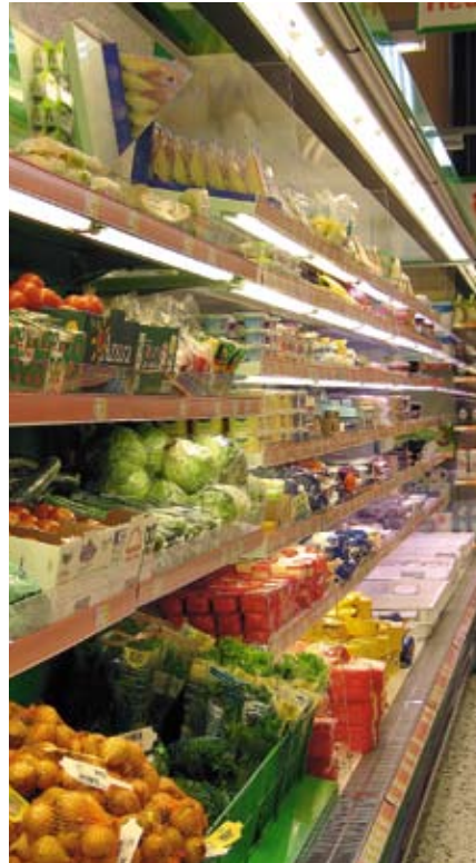
Liikennemyymälässä marketin kylmäkaappien ja elintarvikeshelfyjen eteen laskeutuvat automaattisesti yön ajaksi suojaverhot, jotka pitävät lämpötilan sopivana ja säästävät energiaa.
