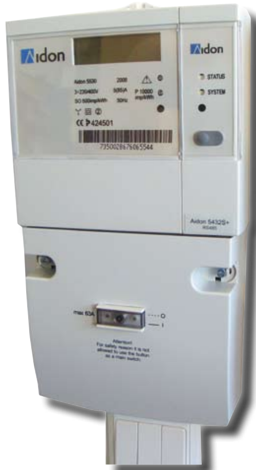
Aidon Oy:n valmistamat uuden sukupolven etälueentamittarit korvaavat vanhat mittarit.
