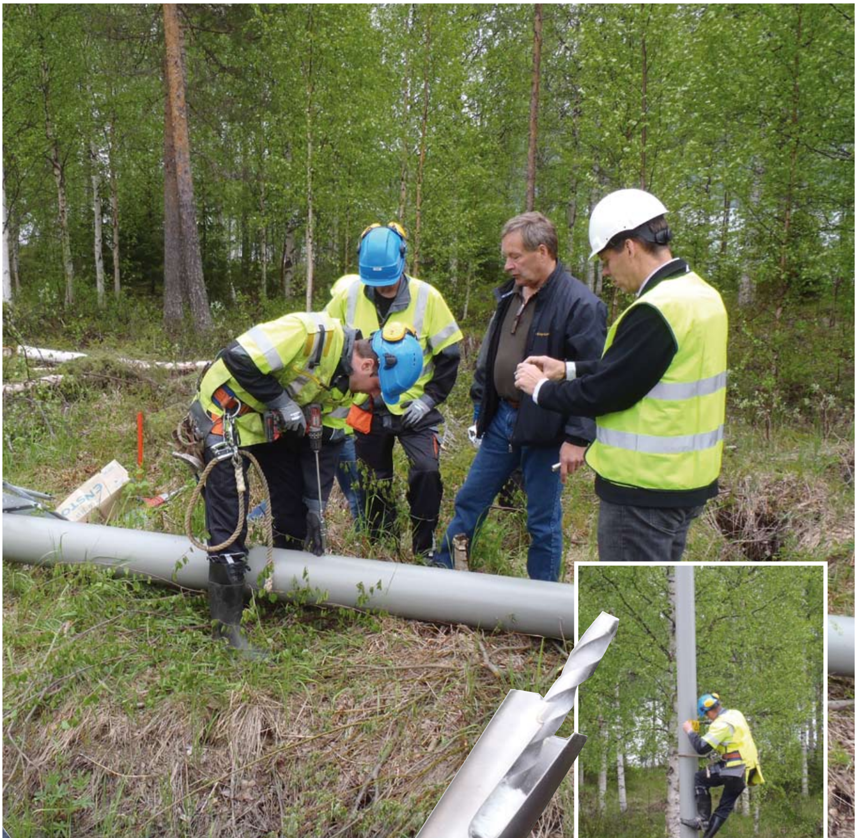
Asentaja Tarmo Posio, Kari Laiho Jerol Oy:stä ja tuotealuepäällikkö Jarmo Harttunen seuraavat kun asentaja Jukka Särkelä poraa reikää komposiittipylvään runkoon.
