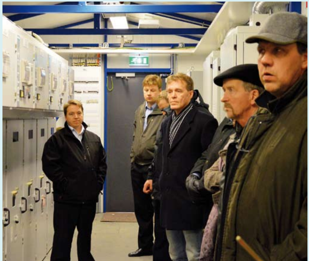
Koillis-Lapin Sähkö Oy:n hallituksen jäseniä tutustui uuteen sähköasemaan. Oikealta hallituksen puheenjohtaja Antti Kerkelä, hallituksen varapuheenjohtaja Veikko Lehikoinen, hallituksen jäsen Ahti Majava sekä asemaurakan toteuttaneen VEO Oy:n liiketoimintajohtaja Visa Yliluoma ja projektipäällikkö Jaakko Alaluusua.
